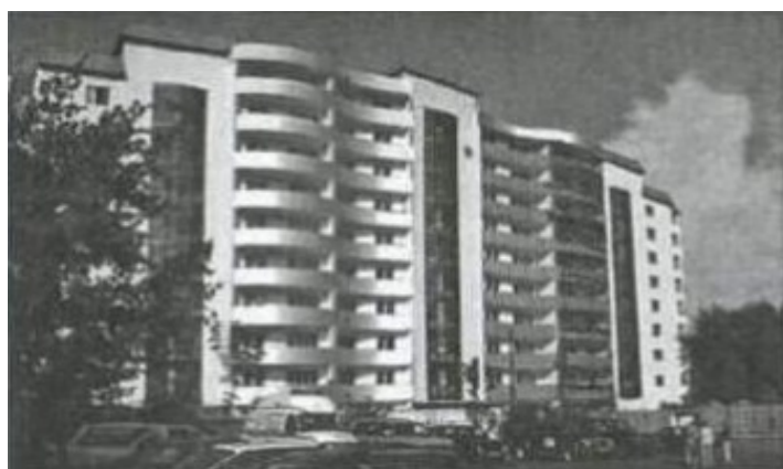
Рис. 6. Дом на кинематическом фундаменте в г. Алматы
