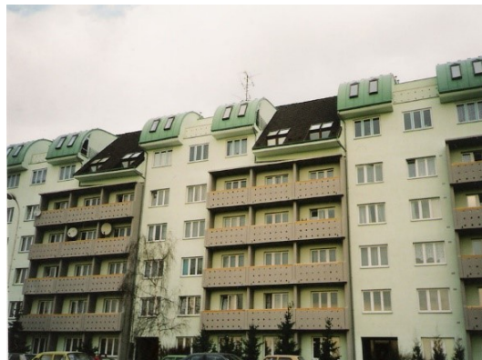
Рис. 3. Строительство нового фасада поверх старого
