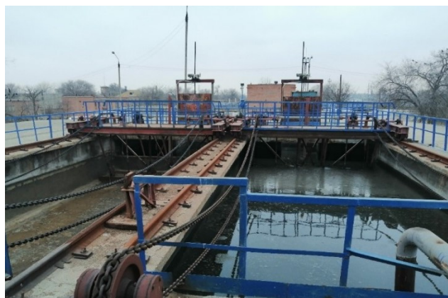
Рис. 2. Горизонтальная песколовка
