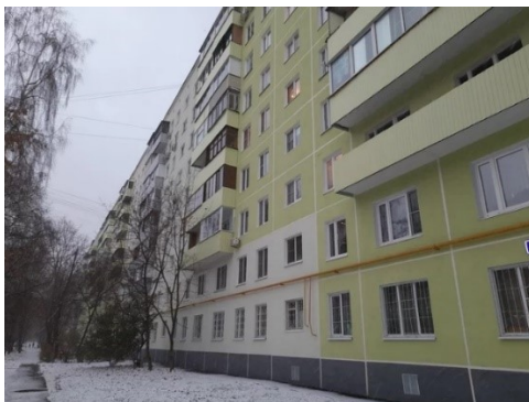
Рис. 1. Здание на территории СНГ после капитального ремонта
