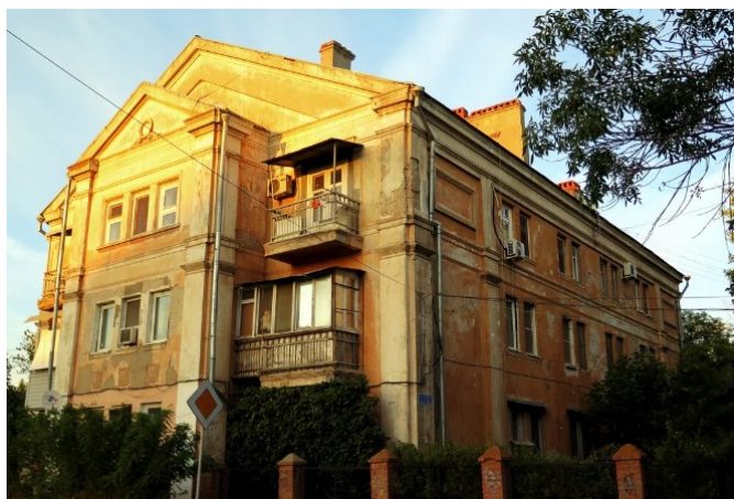
Рис. 4 Лютеранская церковь в г. Астрахани (современный облик)
