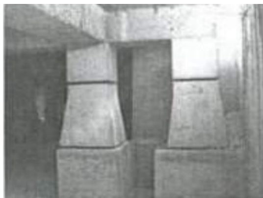
Рис. 7. Фрагмент подвала с кинематическим фундаментом
